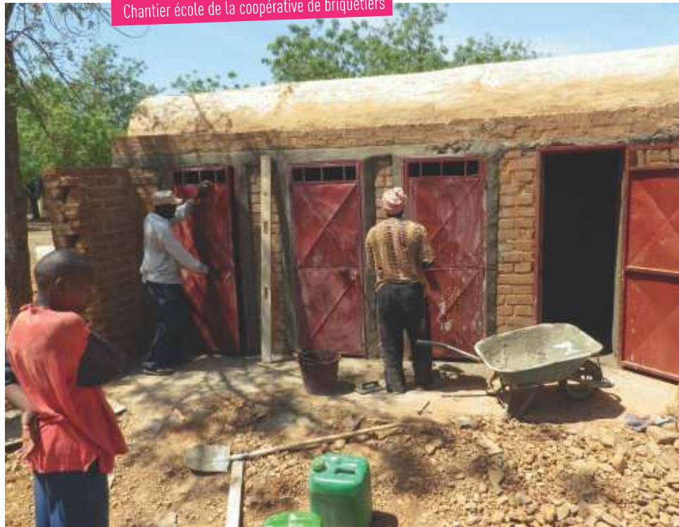
Chantier école de la coopérative de briquetiers
