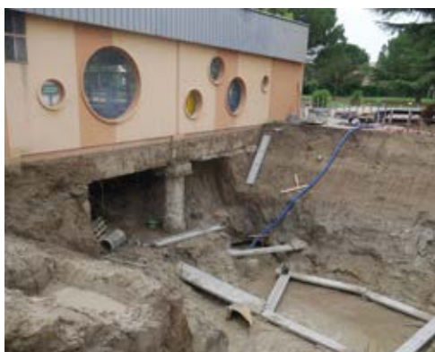
▲ Travaux à la piscine municipale le 21 juillet dernier : ici l'énorme fosse qui accueillera le nouveau local de traitement des eaux, tandis qu'à l'intérieur du bâtiment, mobiliers, sanitaires, revêtement des murs, plafonds et sols ont été retirés pour être entièrement reconstruits.
