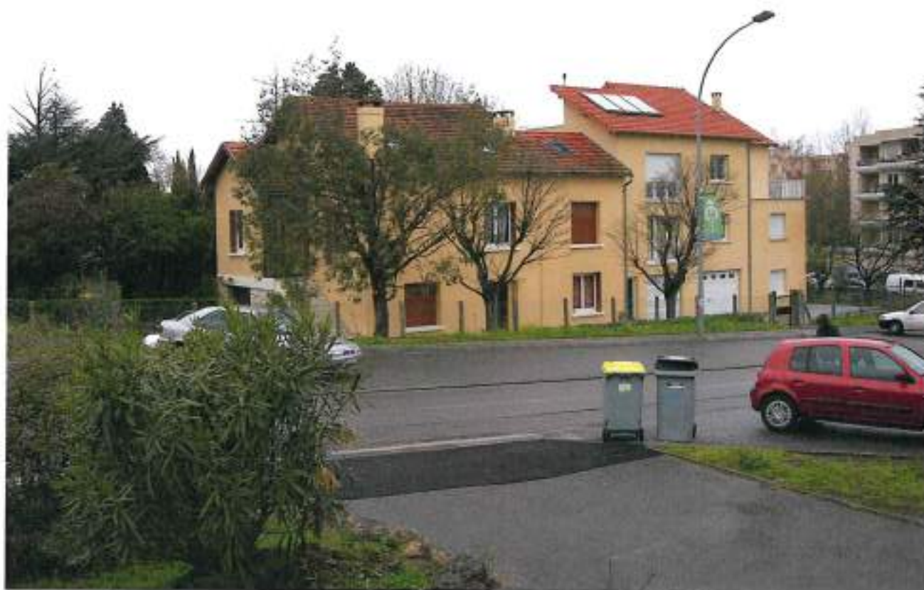
— TOITURE ET TERRASSES EMBLACEMENT FUTUR ASCENSEUR.jpg —
