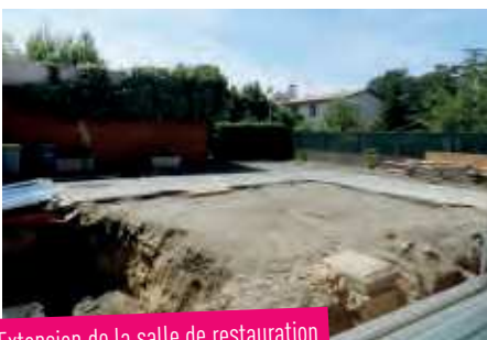
Extension de la salle de restauration
